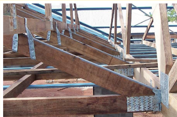
Obr. 6.21 Příklady spojení dřevěných konstrukcí.
