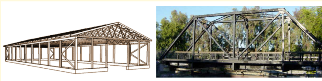
Obr. 6.20 Typické aplikace příhradových konstrukcí.
