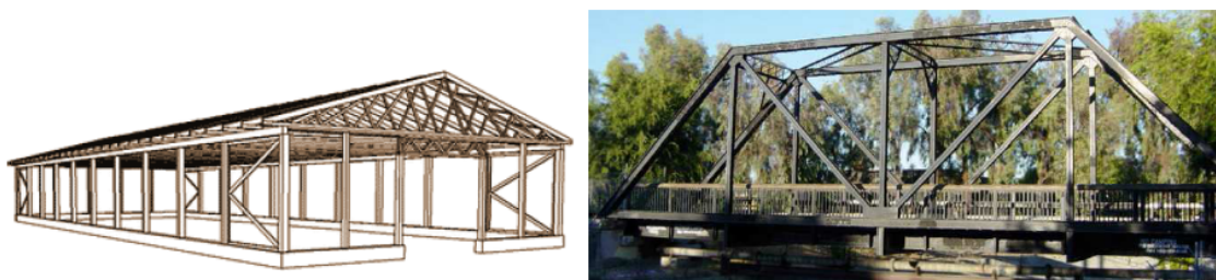
Obr. 6.20 Typické aplikace příhradových konstrukcí.
