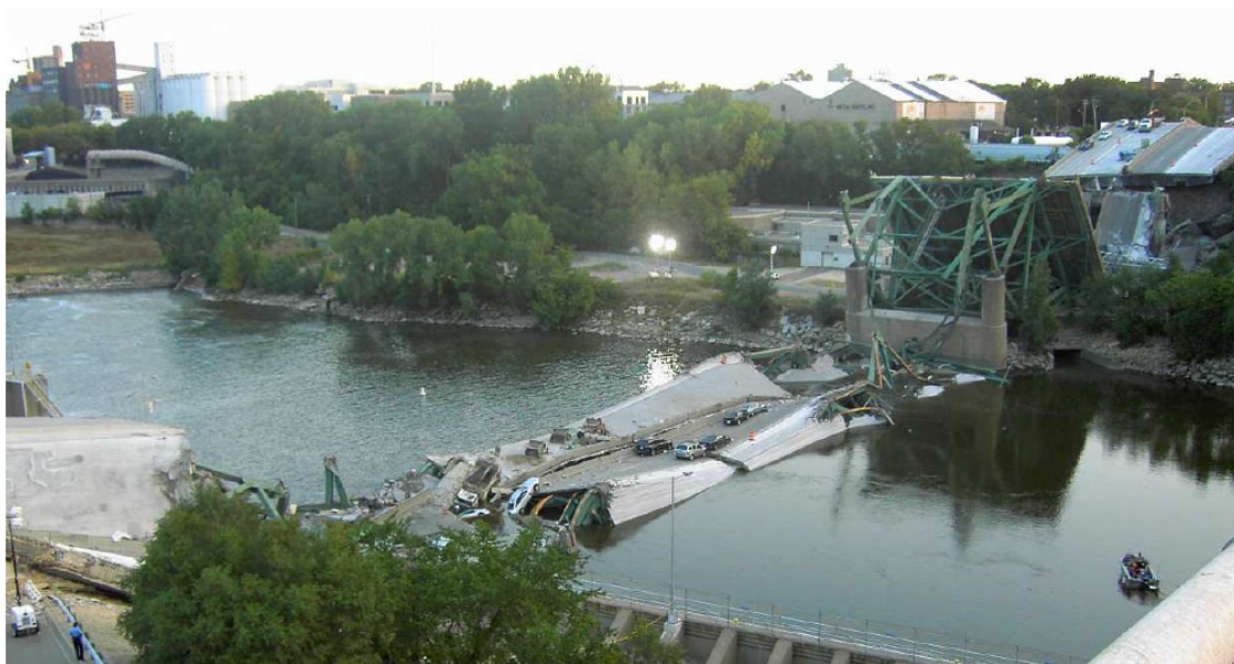
Obr. 9.1 Náhlý kolaps osmiproudového dálničního mostu I – 35W Mississippi River bridge dne 1. srpna 2007, ve státu Minnesota, USA (zdroj: http://cs.wikipedia.org/wiki/I-35W_Mississippi_River_bridge ).
