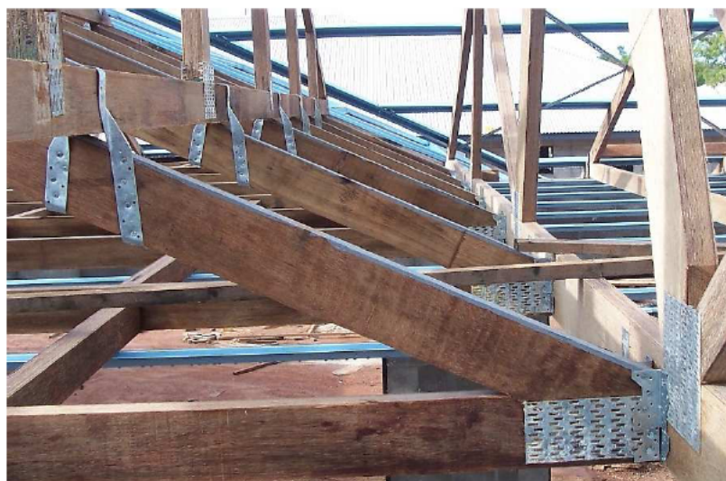
Obr. 6.21 Příklady spojení dřevěných konstrukcí.
